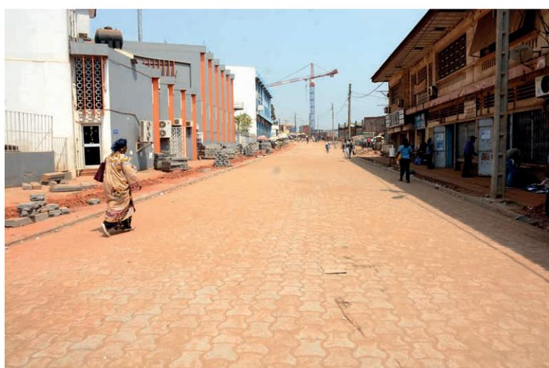
Compte tenu de l'environnement agressif du marché (présence de déchets solides et liquides, humidité), une structure de chaussée rigide en pavés a été privilégiée pour la couche de roulement. Cette solution a été choisie pour éviter la dégradation rapide que subirait un béton bitumineux (enrobé) sous l'effet des réactions chimiques avec les déchets ménagers et alimentaires.
